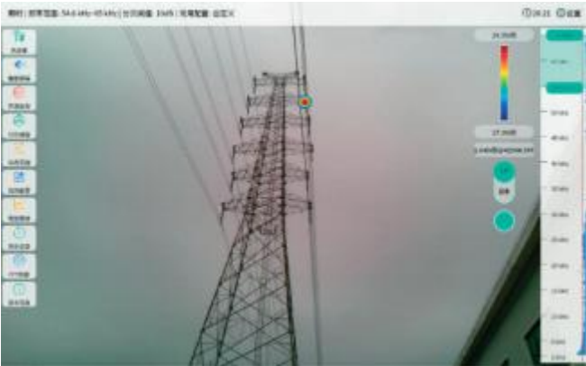
主网高压电塔局放
